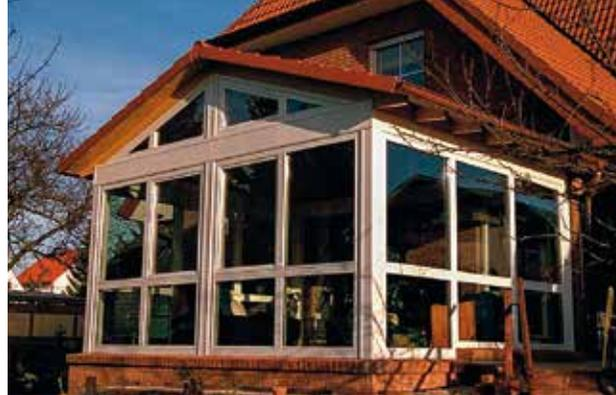
Das Wintergartendach muss nicht zwangsläufig aus Glas bestehen. Auf Wunsch der Bauherrschaft kann der Raum auch ein Ziegeldach erhalten. Der Dachbereich wird dann aus einer Holz-Leimbinderkonstruktion erstellt, mit senkrechten Elementen aus Aluminium. Das Dach wird von unten mit einer Untersichtsverkleidung z.B. aus Holz oder Rigips gedämmt.
